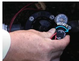
**Paso 2 – instalar y conectar el controlador de válvula**
